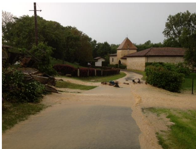
Coulée de boue – traversée de rue (Mairie de Rarécourt)
